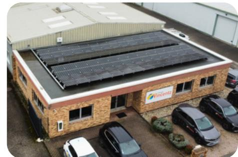
ÉLECTRICITÉ VINCENTZ NORD ALSACE a installé une centrale photovoltaïque de 21 kWc sur site de Geispolsheim, composée de 56 panneaux couvrant 102 m<sup>2</sup>. Le projet intègre également deux bornes de recharge, une borne 2x22 kW à l'avant et une de 22 kW à l'arrière du bâtiment. Cette mise en place contribue à réduire l'empreinte carbone du site tout en facilitant le développement de la mobilité électrique.
