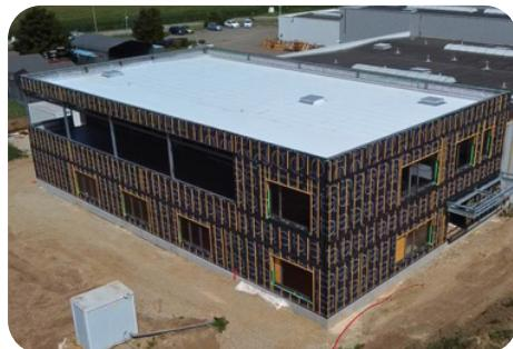
L'extension du site de Niederhergheim s'inscrit dans une démarche environnementale structurée. Le chantier applique les principes du 5S pour limiter les déchets et optimiser les flux et garantir un environnement de travail propre et sécurisé. L'enveloppe du nouveau bâtiment, conçue en ossature bois, réduit l'empreinte carbone et s'inscrit pleinement dans les engagements du Groupe VINCENTZ.
