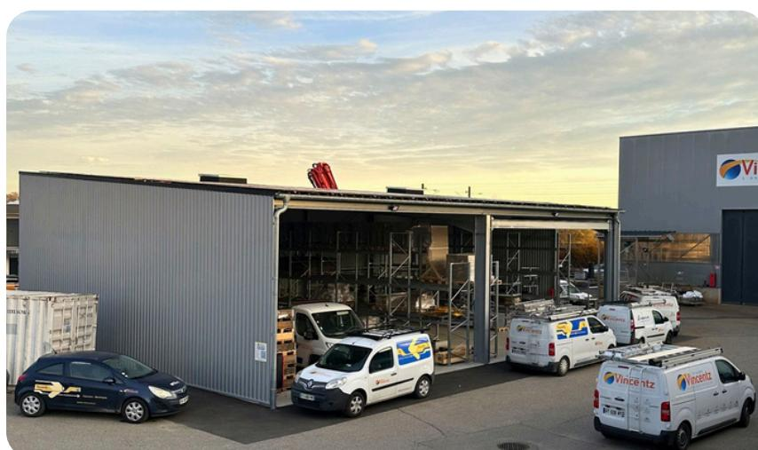
À Sierentz, le nouvel auvent optimise les flux et les zones de stockage. Sa toiture accueille 145 panneaux photovoltaïques (80 kWc), renforçant la transition énergétique du site et réduisant son empreinte carbone. Cette installation améliore également la sécurité, optimise les espaces et renforce la fluidité des opérations pour l'ensemble des équipes.
