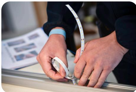
CONCEPT LIGHT met en œuvre une démarche de rétrofit LED en conservant le corps des luminaires et en modernisant uniquement la source. Après évaluation et prototype, la solution est déployée. Cette approche réduit les déchets, l'empreinte carbone et encourage une utilisation responsable des équipements.
